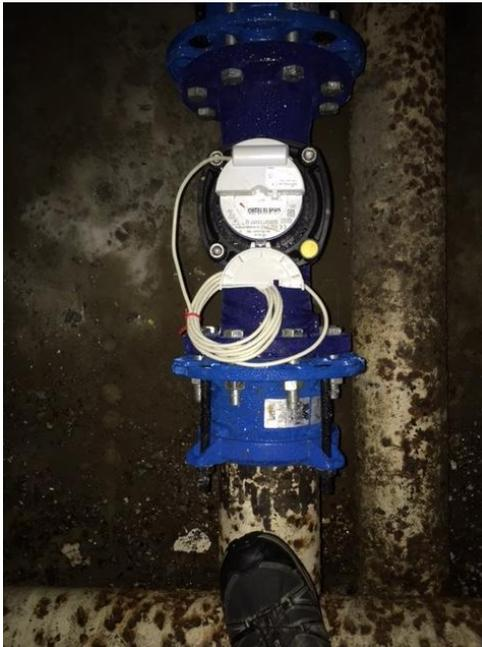
Le compteur situé en sortie du réservoir de l'ateu, qui dessert le bourg, a été remplacé car il avait plus de 15 ans. Un compteur identique a été installé en sortie du réservoir de Servières
